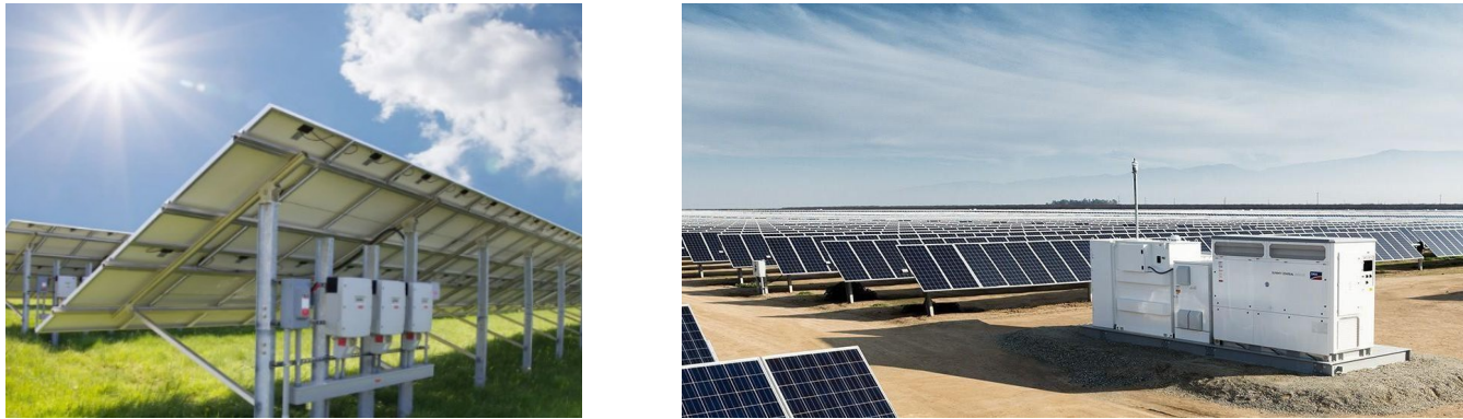
Illustration 73: Comparaison de différents onduleurs : strings (onduleur solaire, s.d.) ou centralisé (SMA, s.d.)
