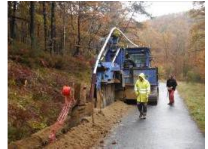
Illustration 85: Exemple de pose de câbles à la trancheuse
