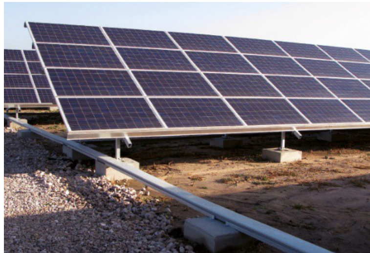
Illustration 72: Exemple de pose de câble sur un chemin de câble DC ou souterrain AC/HTA (Comportement intempérie, s.d.) (Règles électricité entérées, s.d.)
