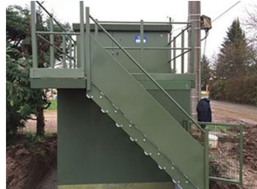
Illustration 74: Exemple de poste de transformation et de livraison HTA/BT réhaussé (rehausse pssa, s.d.)
